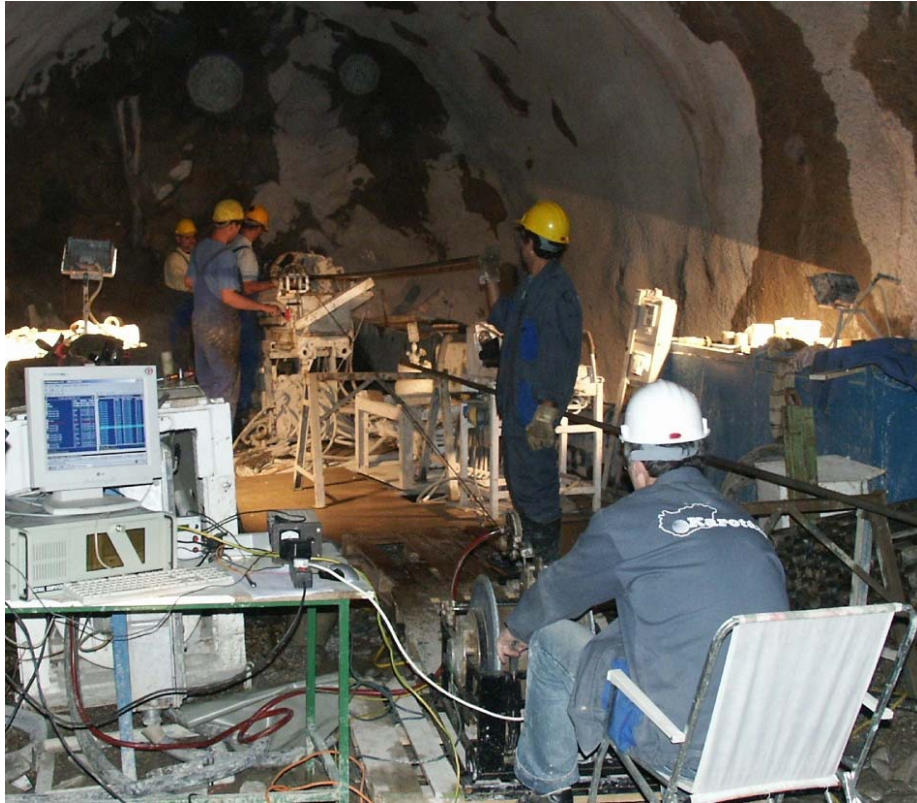
4.5. ábra : Bátaapáti, a szonda betolása
